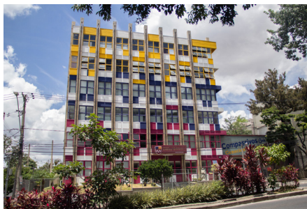
Prédio A – Pe. Agostinho Castejón, SJ
